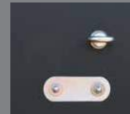
Montage materialen voorzien van grote onderlegplaten: eerst r.v.s. en daaronder rubber
