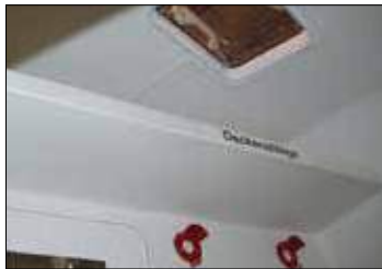
Opbergruimte boven de doorgangsdeur in zadelkamer
