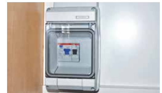
Verteilerkasten mit FI und Sicherung (16 Ampere)
